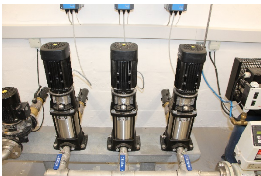
Rentvandspumper på Reerslev Vandværk. Vandmålere og prøvetagningshaner fra borerne.
