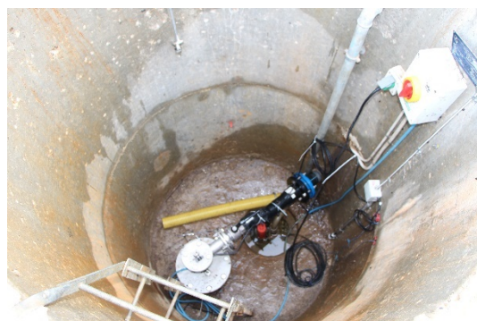
Tørbrønd til boring med DGU nr. 207.2697.
