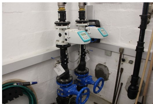
Rentvandspumper på Reerslev Vandværk. Vandmålere og prøvetagningshaner fra borerne.
